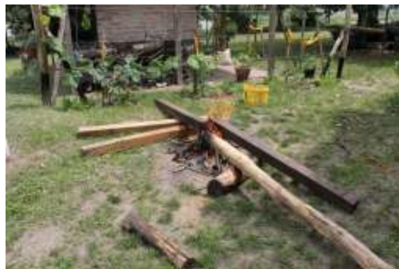
Oszlopok égetése, "pörkölése", hogy hosszú távon megóvjuk a korhadástól. Az égetés szakszerű munkáját Notter Béla végezte.
