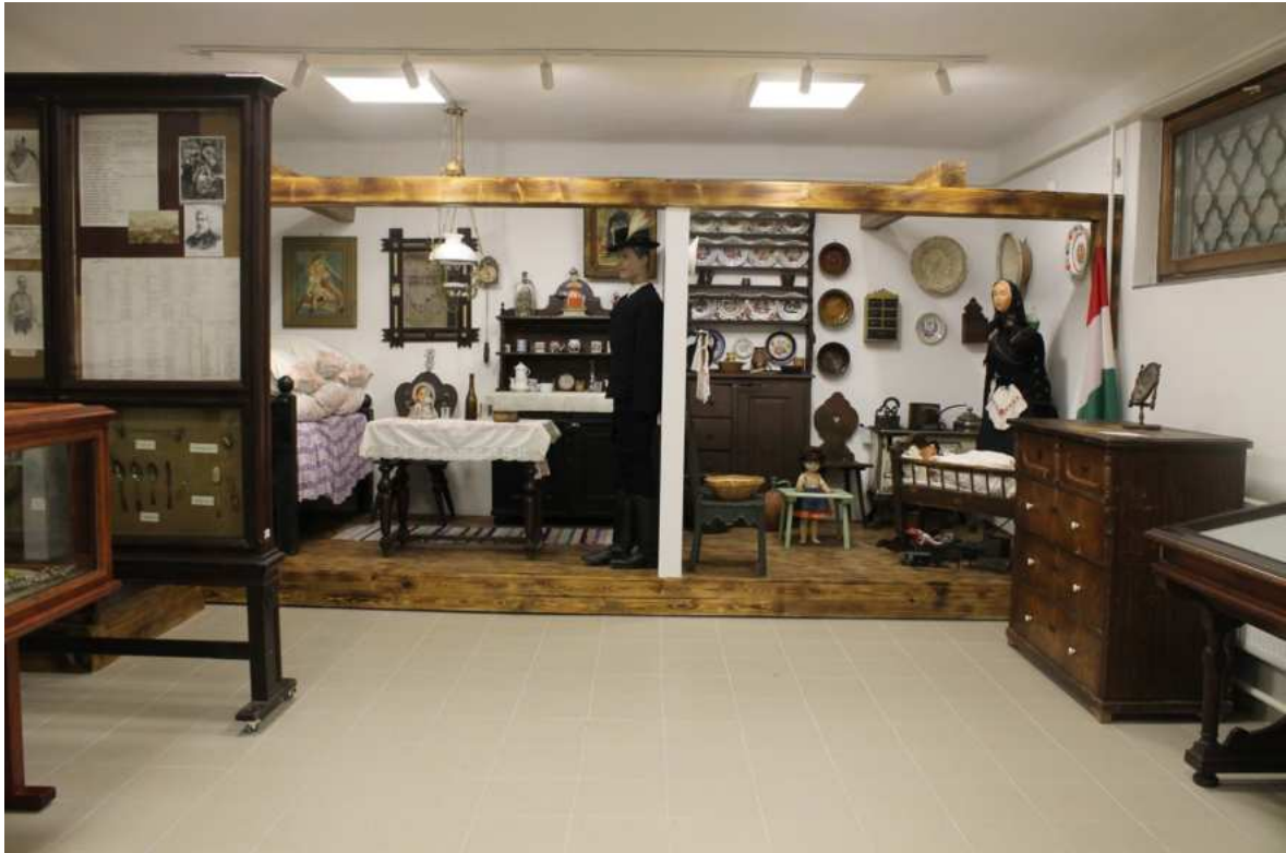
2018-ban felújított Isaszegi szoba és konyha enteriőr, kiemelve a járószintből, szendvics panellel elválasztva egymástól a szoba és konyha. A fotón az elavult PVC padló helyett már az új gres járólapok láthatók.
